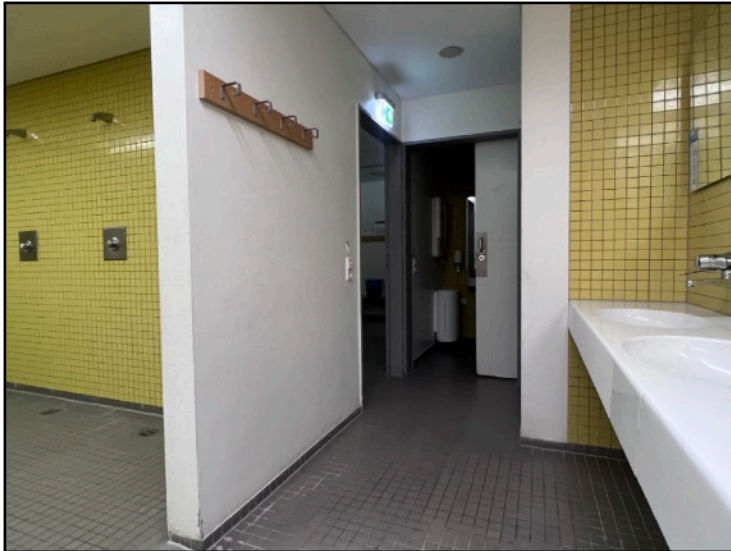
Abb. 24 (rechts): Schiebetür im Flur für zuschauende Gäste (allgemein keine Unfallgefahr durch aufgehende Tür)
